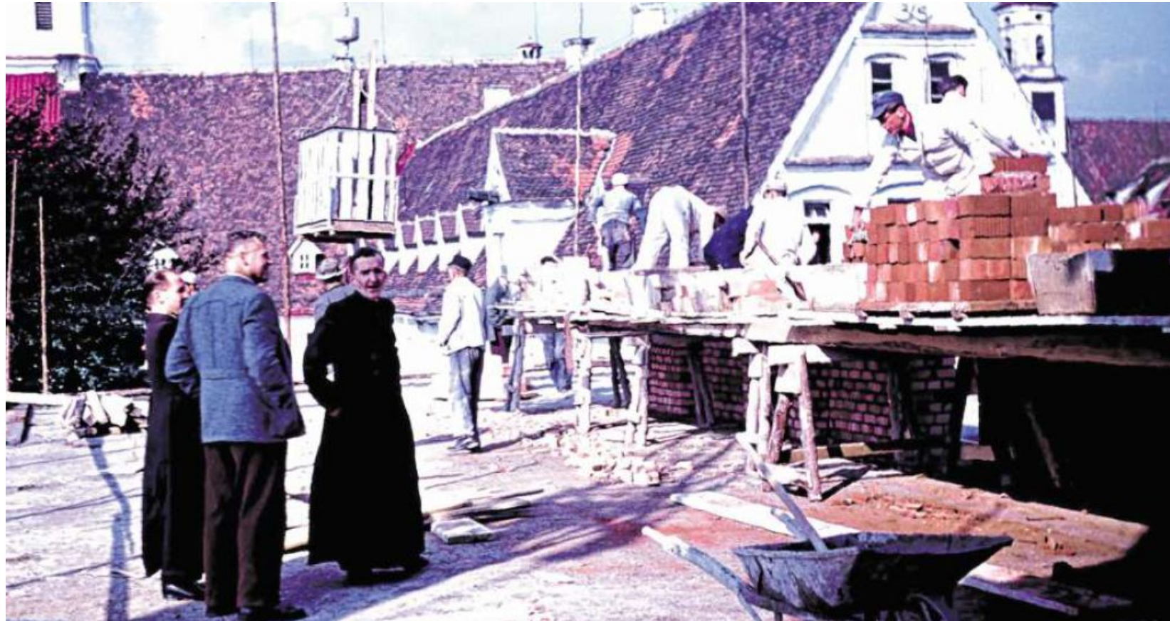
Mit der Verlegung der Oberstufe von Benediktbeuern nach Buxheim wird das Marianum zu einem Vollgymnasium erweitert. Dazu musste ein neues Oberstufengebäude gebaut werden. Das Bild stammt aus dem Jahr 1963 und zeigt den Rohbau dieses damals größten Bauprojekts des Landkreises Memmingen. Repro (3): Walter Müller
